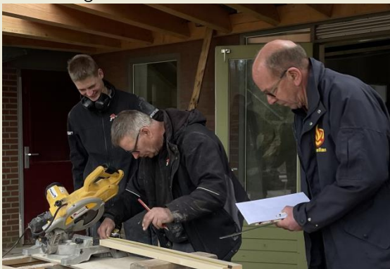
Gerrit, Hans en Bas in overleg over bouwzaken
