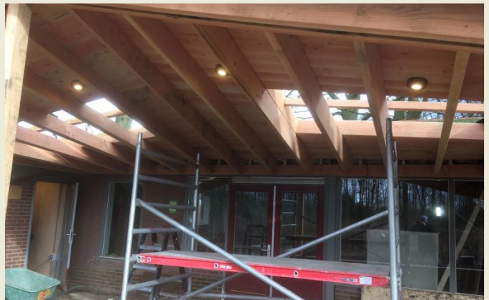
Frits heeft de verlichting onder de overkapping aangesloten
